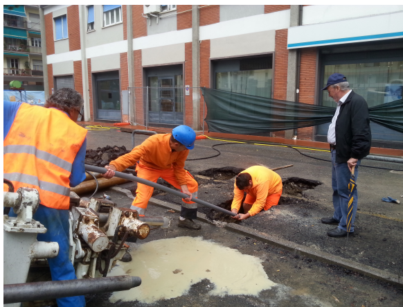
Inserimento del tubo a valvole
