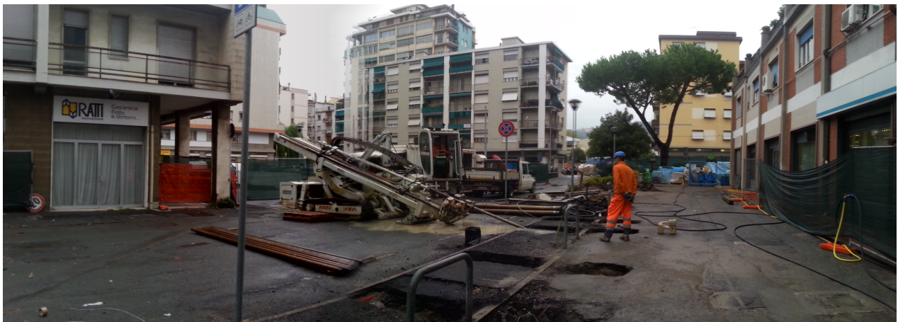
Perforazione teleguidata
